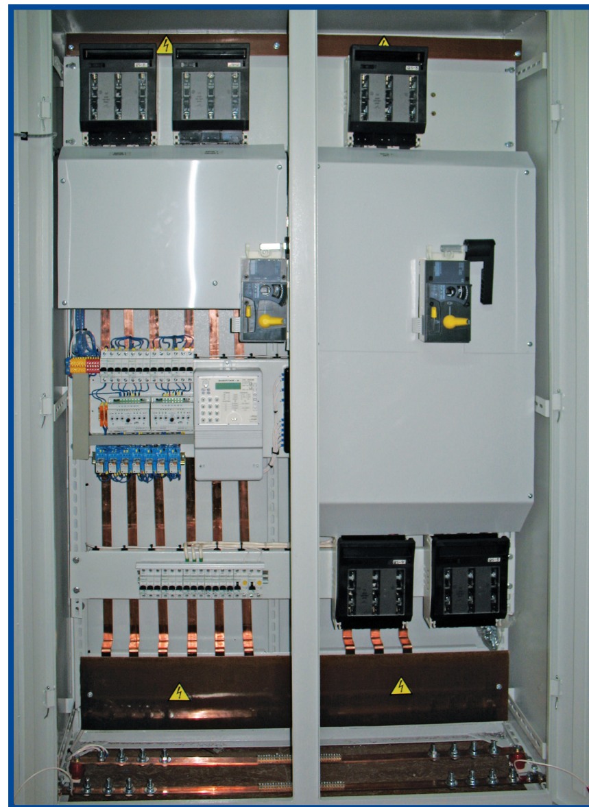
АВР на 3 вводи на базі перемикаючого вимикача навантаження АТYS
